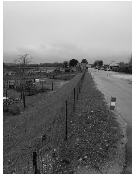
Des travaux de terrassement ont été réalisés sur la route départementale 187, afin de renforcer le talus en contrebas et assurer une meilleure canalisation des eaux pluviales. Un grillage a été mis en place afin de sécuriser l'accès piéton. Le muret en pierre est en cours de reconstruction. Ces travaux ont été intégralement pris en charge par l'Agence départementale de l'aménagement.
